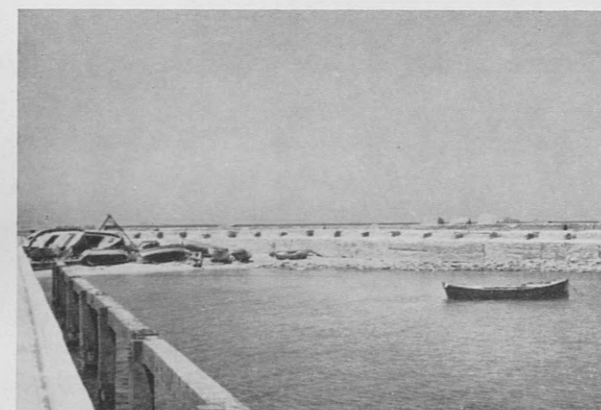
Zuara Marina: barche in ri- parazione nel piccolo cantiere
