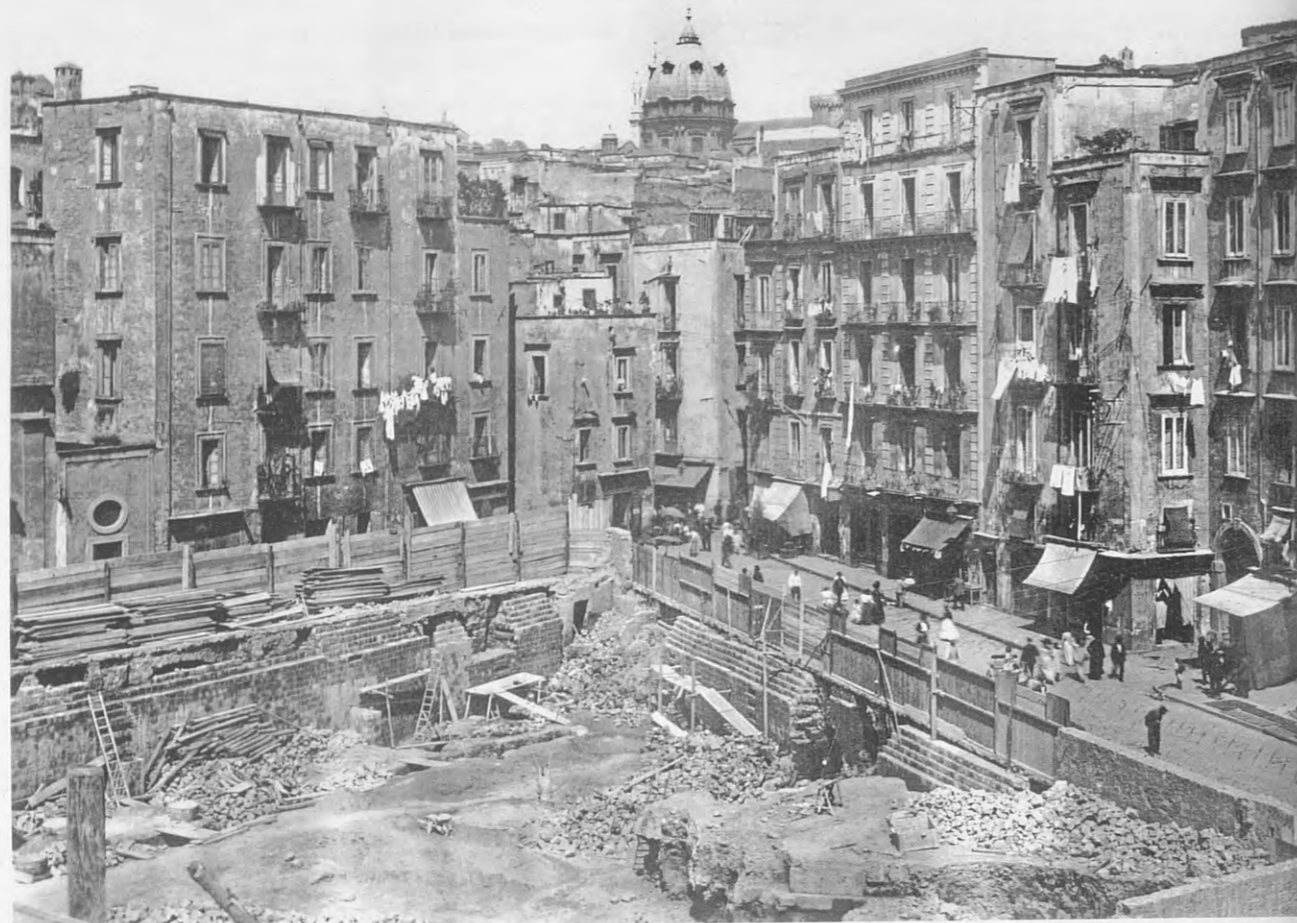
Fig. 1. Piazza Calenda. Nella foto è ripreso il cantiere per la costruzione dell'edificio del teatro dopo l'abbattimento degli edifici preesistenti, nell'angolo in basso a dx. si nota la torre (1910, inv. 3648).
