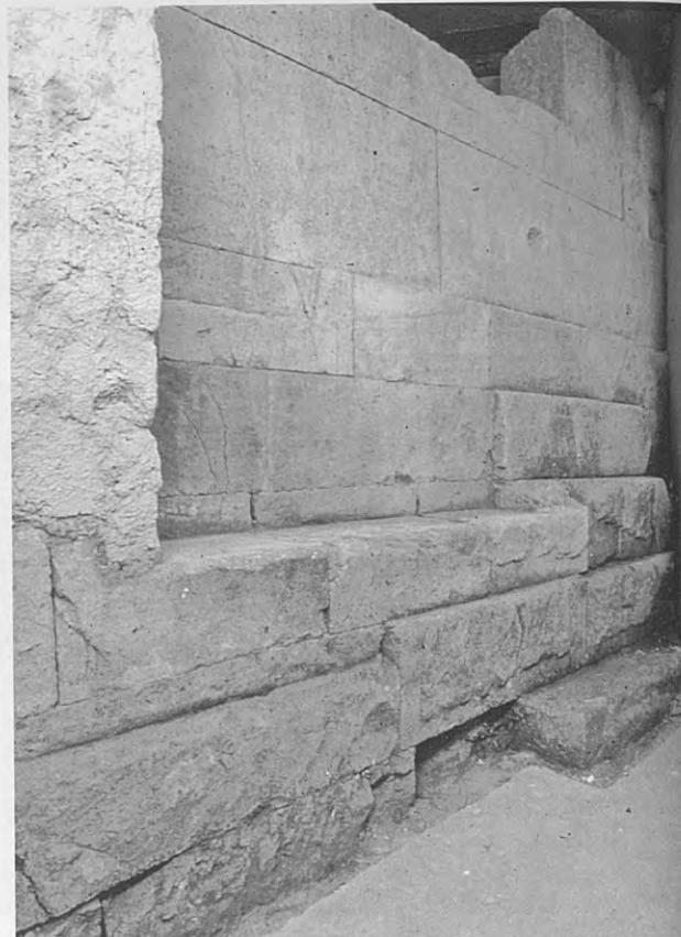
Fig. 9. Piazza Calenda. Cortina nord della torre (USM 15). Situazione attuale.
