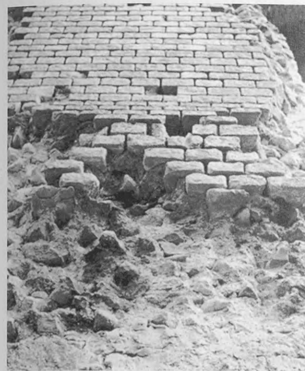
Fig. 7. Esempio di opus vittatum : l'acquedotto di Metz (Adam 1988).
