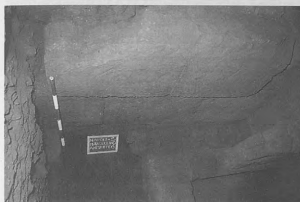
Fig. 14 - S. Marcellino, ambiente 6: in basso cortina muraria in ortostati di fine IV sec. a.C., in alto cortina muraria in ortostati di III sec. a.C.
