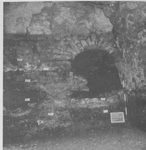
Fig. 12 - S. Marcellino, ambiente 4: struttura termale, parete nord con i forni.
