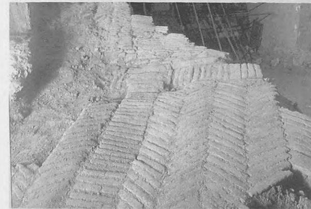
Fig. 3 - S. Marcellino, succorpo della chiesa. Particolare della rampa in laterizi.
