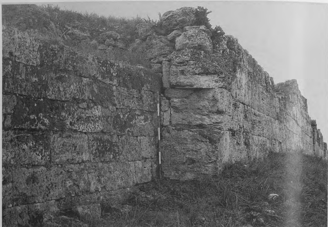
1. Settore nord/est. Particolare del paramento esterno della cortina con le due fasi edilizie.
