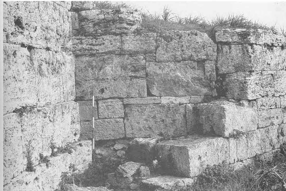
1. Particolare dell'innesto della torre 2 con il paramento interno della cortina 1-2.
