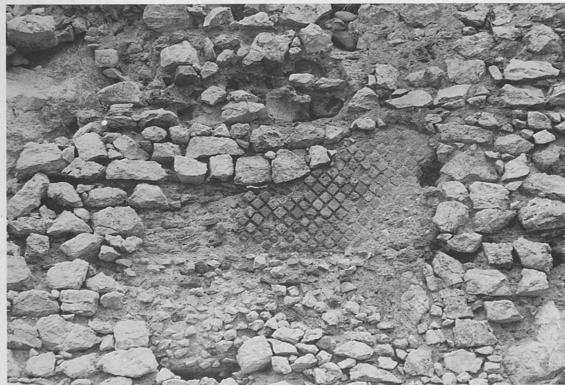
2. Tratto del paramento in opus reticulatum inglobato nel basamento della torre.
