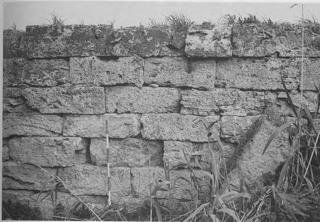
1. Particolare del paramento esterno del muro interno (lato verso la città).
